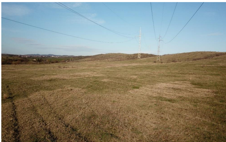
Фиг. 8 Изглед към ПИ 44425.12.26, м. „Вилите“, землище на с. Лъка, община Поморие, през който преминават два съществуващи въздушни електропровода 110kV – „Ахелой“ и „Ветрен“
